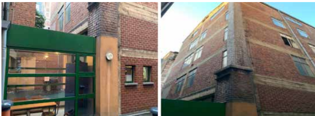
Vues sur les façades est et sud du volume arrière
