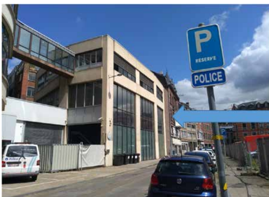
Rue Florimont Rez tadam (phase 2) /Etage AES (Phase 3)
