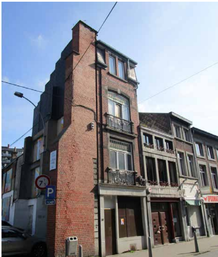
Rue Sainte-Marguerite n° 30 (avec ses contreforts) et n° 28. Crédit photographique : S. Kech
