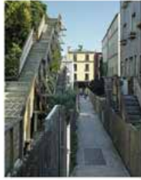
Eden Bio, Paris - densification d'un îlot faubourien : construction en intérieur d'îlot et cheminements via de fines venelles. Le sol original a été remplacé par un sol profond organique.
