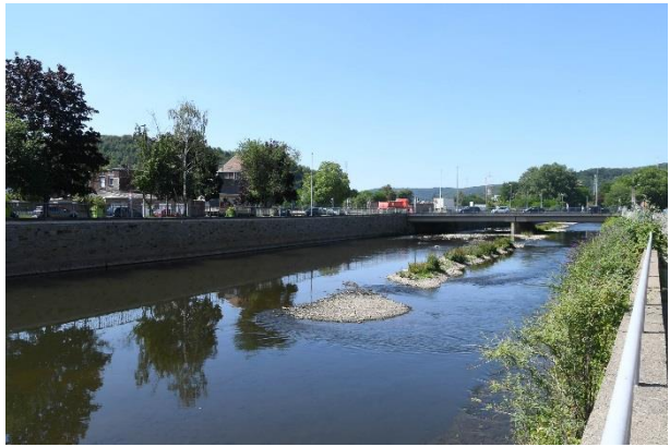
Photo n°73 – Vesdre et pont du Lhonneux
