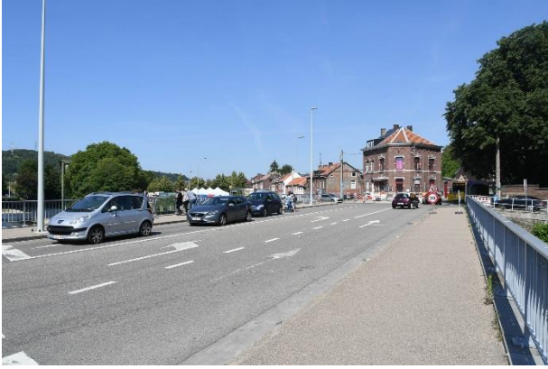
Photo n°64 – pont du Lhonneux
