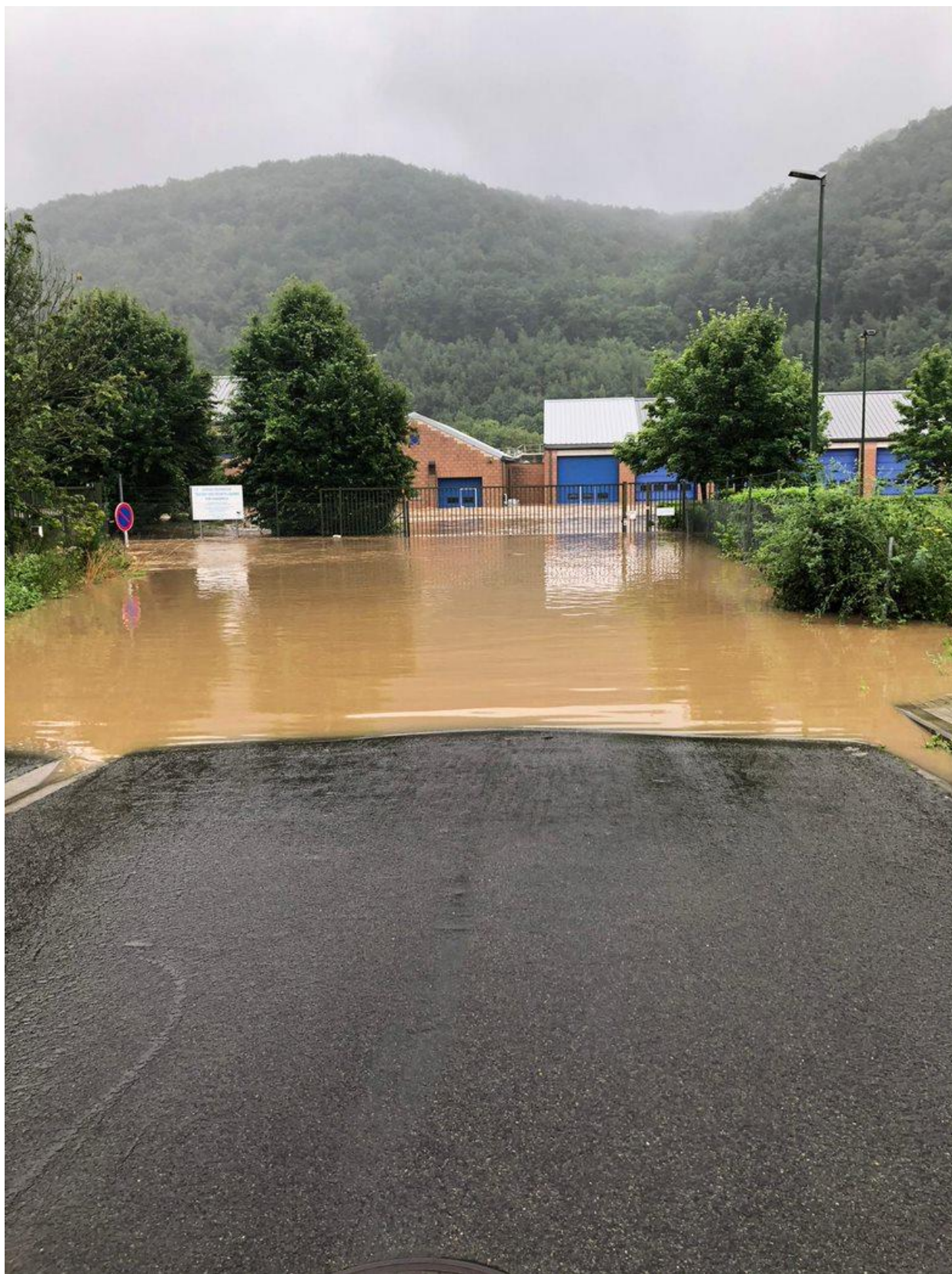
Pepinster - Station d'épuration de Wegnez - 14 juillet 2021.
