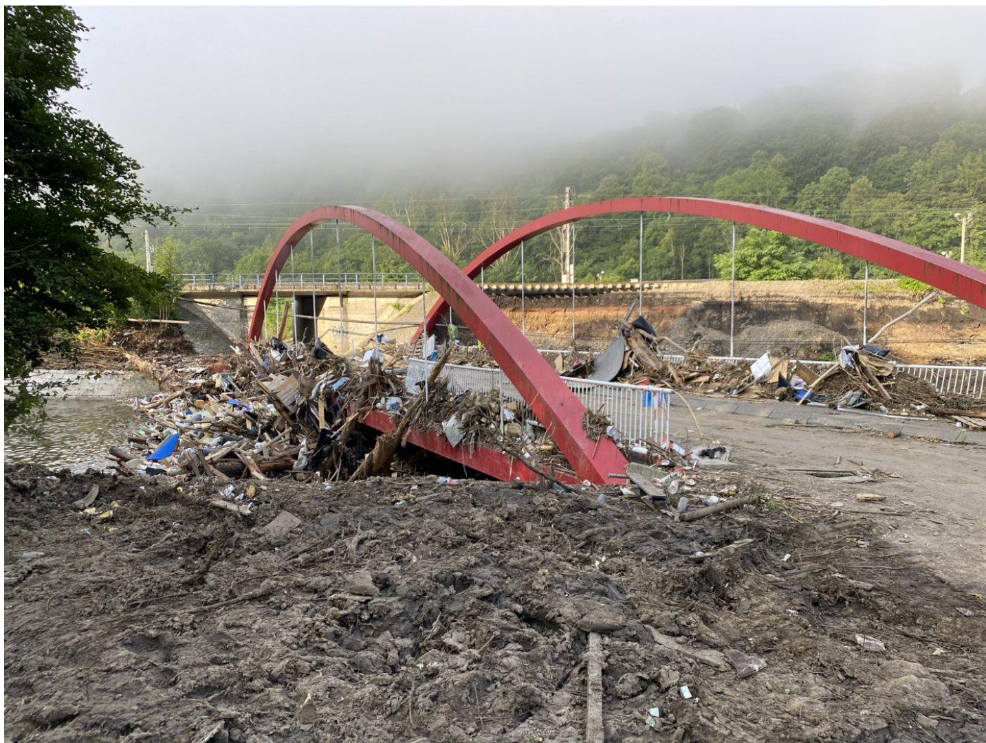
Chaufontaine - Pont d'accès à la station d'épuration de la Brouck - 18 juillet 2021.
