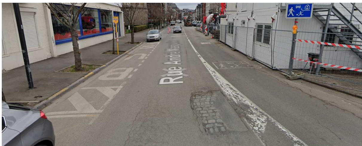
Vues générales prises en mars 2021 depuis l'Ouest de la Rue Masquelier vers l'Est de la rue
