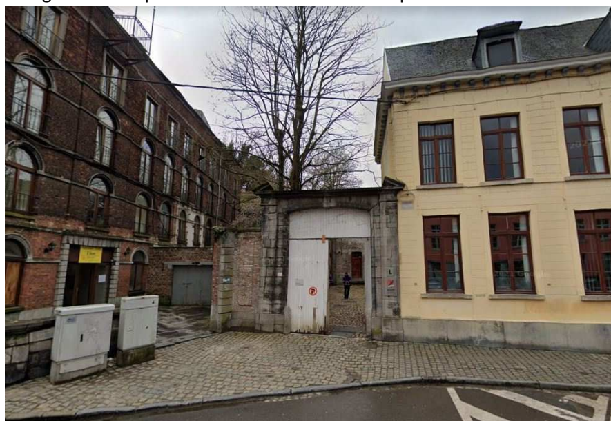
Vue générale du porche d'accès côté Rue Lamir prise en mars 2021
