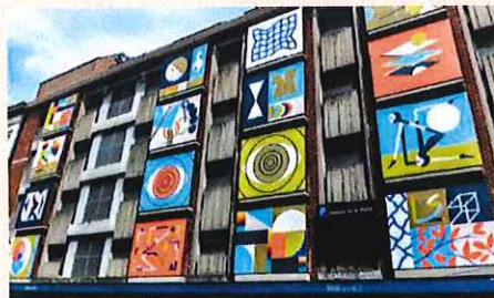
L'œuvre du collectif Hei'O transforme une façade de parking en un véritable polyptyque urbain. © OSWALD TLR
